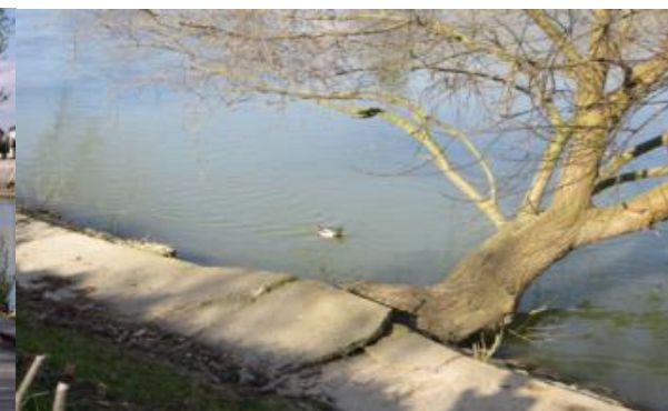
Caractère minéral d'une partie des berges
