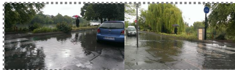
Débordement des réseaux d'eaux pluviales sur la chaussée dans le quartier des bords de Marne
