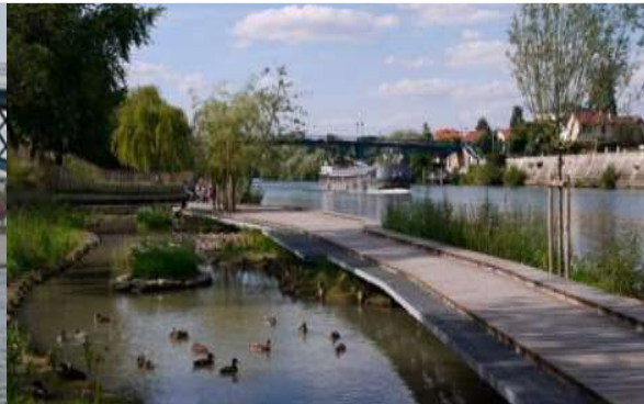
Berges de Marne réaménagées
