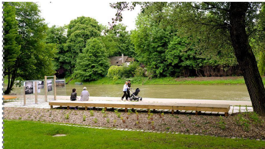
Quai d'Artois et ses nouveaux aménagements, berges de Marne
