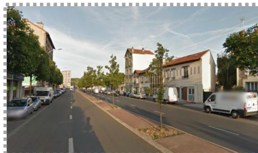
Des hauteurs du bâti progressives à mesure qu'on s'approche des carrefours
